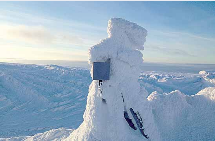
i Рис. 6. Панельная антенна защищена от обмерзания обогревом
