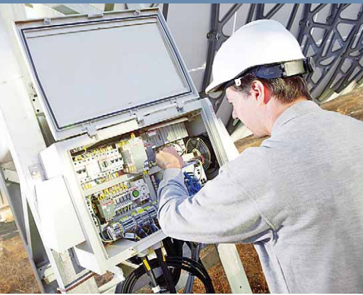
Рис. 4 Протяжка клеммных соединений на нагревательной системе диатермического масла
