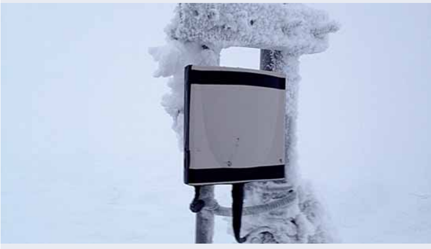
Рис. 6. Панельная антенна защищена от обмерзания обогревом
