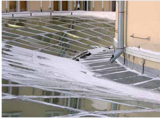
Рис. 3. Светопрозрачное покрытие Международного университета (вид сверху) и примыкания, обогреваемые плитами.
