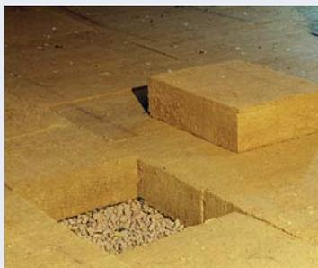
Эти плиты являются не только жёстким теплоизоляционным материалом с отличной паропроницаемостью, но и при сравнении коэффициентов теплопроводности в 4,5 раза эффективнее, чем та же толщина керамзитового гравия.
