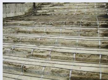
Нагревательные секции НТ укладываются в слое цементной стяжки с креплением на монтажной ленте. Удельная мощность обогрева ступеней сходов составляет 330 Вт/м<sup>2</sup>. (см. рис. 4), площадок и пандусов 250 Вт/м<sup>2</sup> (см. рис. 5).
