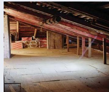
положительную температуру, то есть имел место существенный приток тепла в подкровельное пространство. Что касается трубопроводов, то они были изолированы с помощью армопенобетона, не обеспечивавшего необходимого уровня теплозащиты, так что температура на его поверхности только чуть-чуть не доходила до +30°C.
