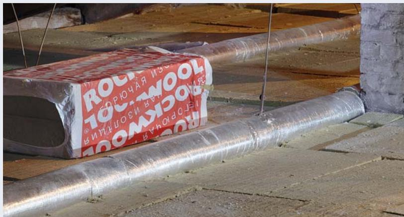
Цилиндры из каменной ваты использовались толщиной 60 и 50 мм (на трубах с диаметром от 89 до 25 мм). Такие толщины обеспечивают соответствие установленным нормам тепловых потерь (рис. 4).
