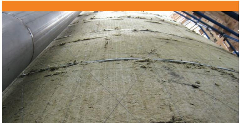
Рис. 5. Вид проволоочных стяжек, фиксирующих плиты теплоизоляции
