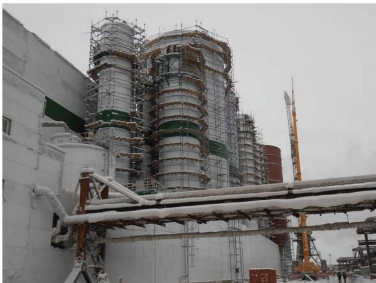
Рис. 10. Монтажные леса вокруг резервуаров
