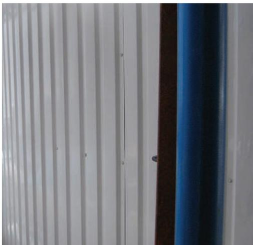
Рис. 7. Защитное покрытие из профилированного листа
