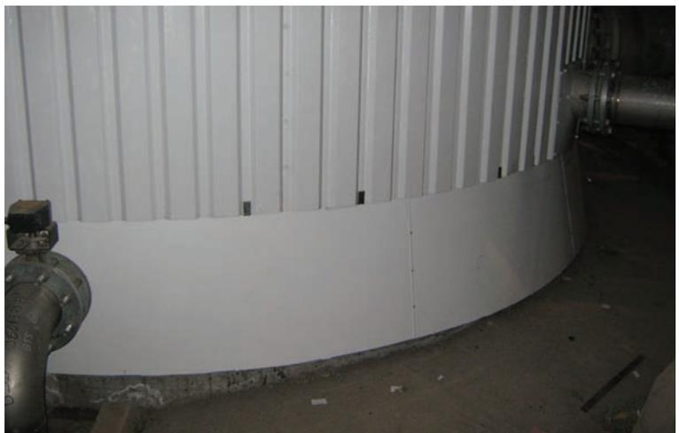
Рис. 8. Низ профилированного листа, установленный в кляммеры
