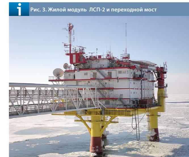
Рис. 3. Жилой модуль ЛСП-2 и переходной мост
