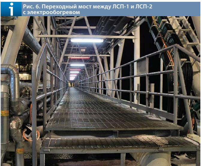
**Рис. 6. Переходный мост между ЛСП-1 и ЛСП-2 с электрообогревом**
