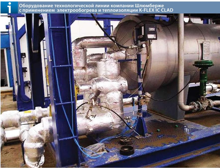
**i** Оборудование технологической линии компании Шлюмберже с применением электрообогрева и теплоизоляции K-FLEX IC CLAD
