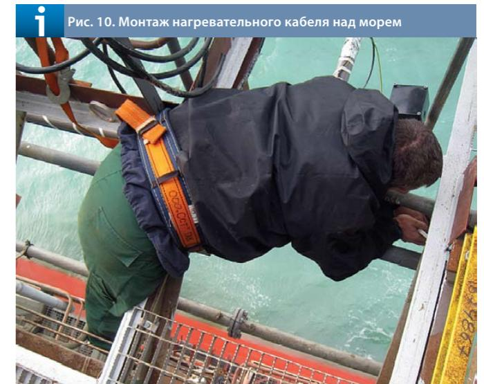
**Рис. 10. Монтаж нагревательного кабеля над морем**
