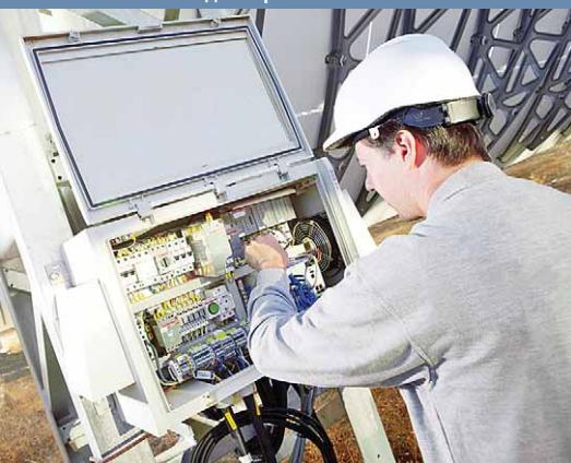
Поэтому, в качестве дополнительной защиты от неточности при установке, изделия имеют асимметричную форму – визуально легко определить, какой элемент смонтирован на DIN-рейке неверно.
