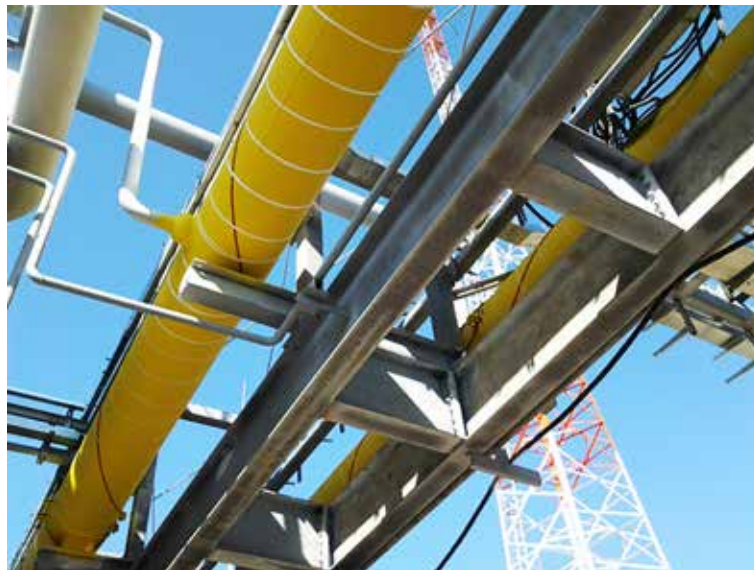
Рис. 3. Фото смонтированного участка обогреваемого трубопровода (до установки теплоизоляции)
