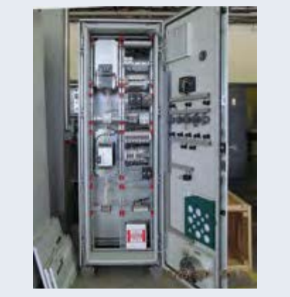
i Рис. 6. Типовой шкаф управления для системы Masterwatt
