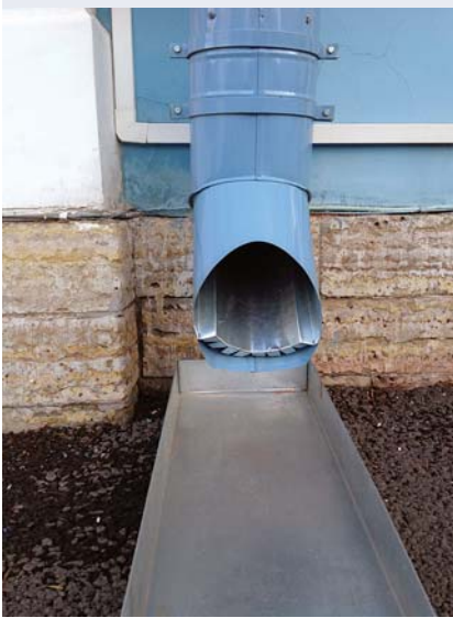
Рис. 2. Оформление отмета обогреваемой водосточной трубы.
