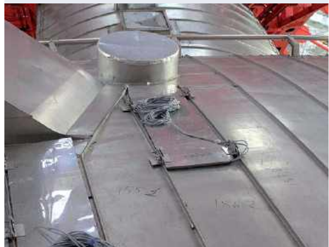
Рис. 5. Крепеж плит к фальцам кровли
