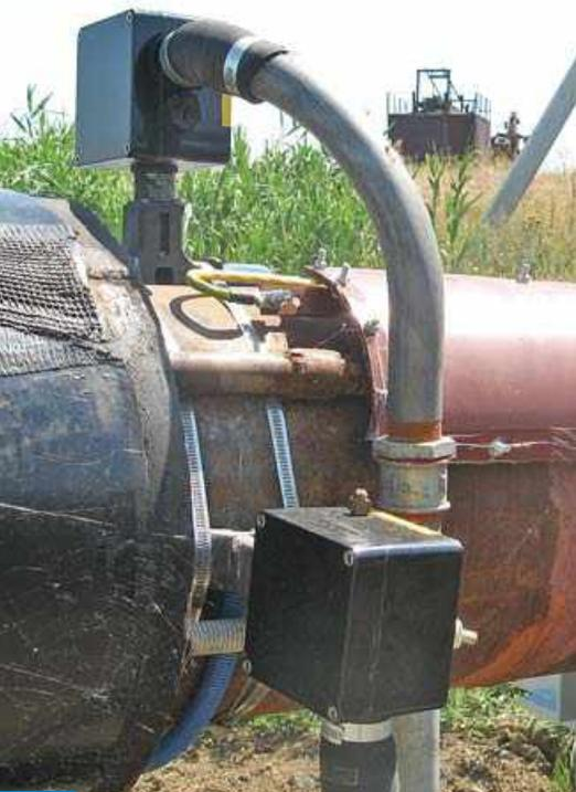
**Рис. 3.** Коробка подключения проводника наземного участка системы ИРСН-15000
