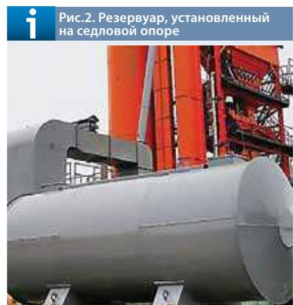
Рис.2. Резервуар, установленный на седловой опоре
