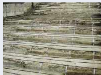
Рис. 3. Лестничный сход подземного пешеходного перехода с разложенными нагревательными секциями
