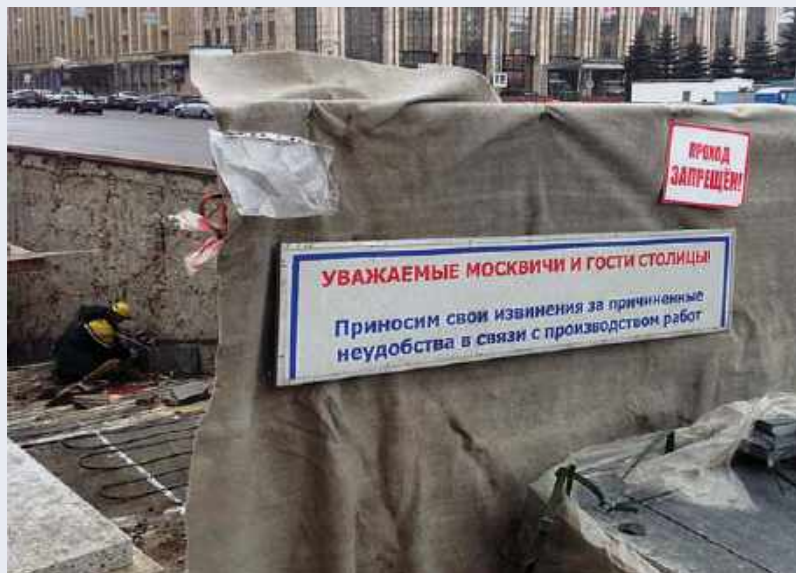
Рис. 1 Процесс установки системы обогрева «Теплотор» на пешеходном переходе
