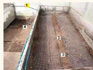
Рисунок 2 – Монтаж оборудования в теплице:
