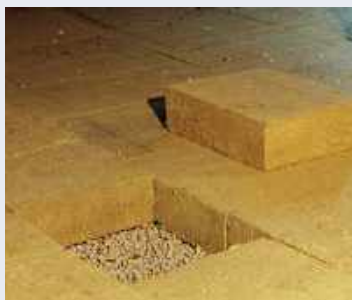
Рис. 2. Укладка утеплителя поверх керамзитовой засыпки
