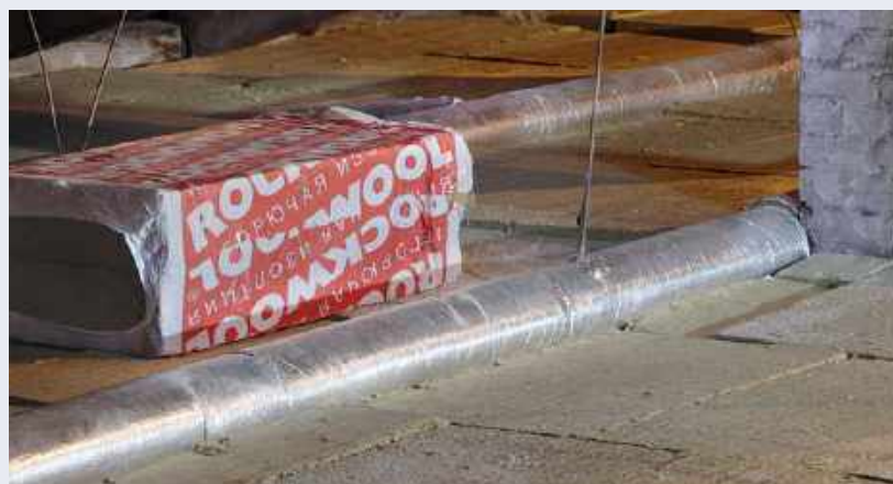
Рис. 4. Утепление чердака
