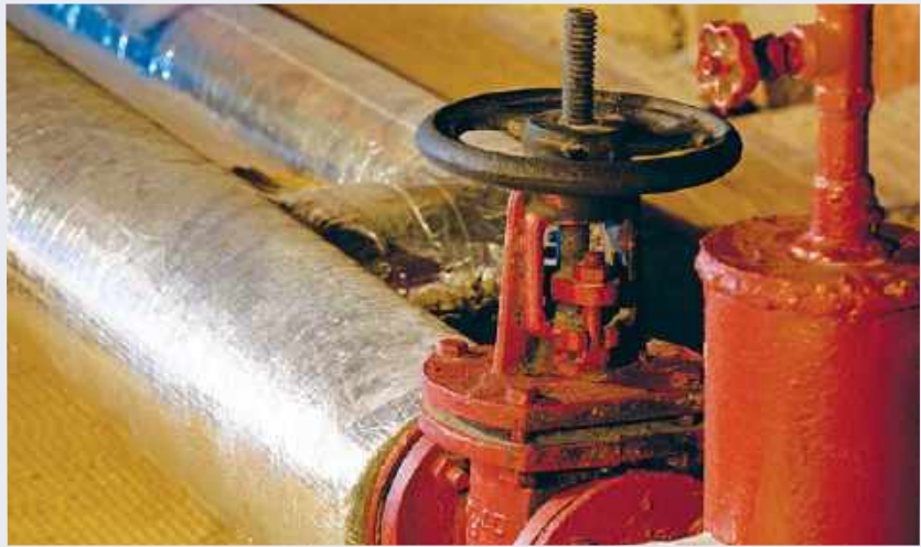
Рис. 5. Утепление трубопроводов
