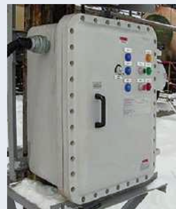
Взрывозащищенное исполнение шкафа, тип «в»
