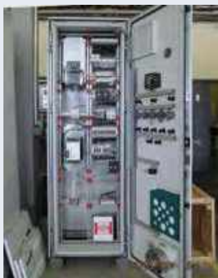
Рис. 6. Типовой шкаф управления для системы Masterwatt
