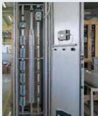
Рис. 7. Шкаф, в котором смонтирована автоматизированная система управления, построенная на контроллерах ОВЕН
