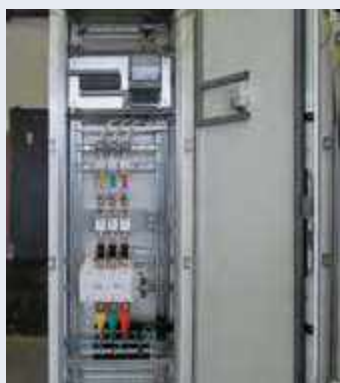
Рис. 9. Низковольтное комплектное устройство (НКУ) подачи питания на систему обогрева.
