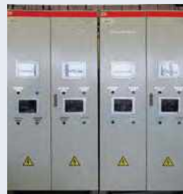
Рис. 8. Шкаф, в котором смонтирована автоматизированная система управления, построенная на контроллерах Wago
