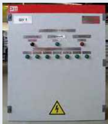
Рис. 4. Типовой шкаф управления для системы «Тепломаг»
