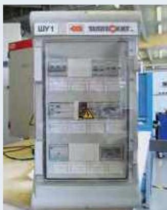
Рис. 3. Шкаф управления для системы «Теплоскат»
