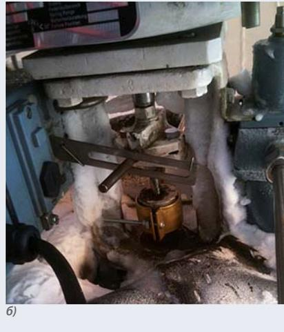
тием из пеностекла и закреплены сверху металлической оболочкой. Пространство между клапаном и корпусом блока разделения воздуха заполнялось минеральной ватой (см. рис. 3, а). Снаружи минеральная вата защищалась резиновой пластиной (см. рис. 3, б).
